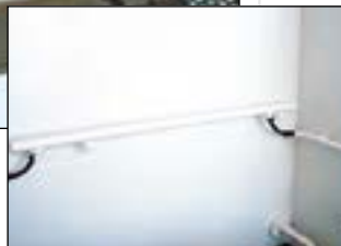
ПОРУЧНИ Чтобы обеспечить безопасную опору для персонала, устанавливается линия обогрева для предотвращения обледенения поручней или удаления льда с них.
