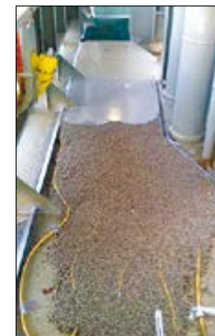
МОРСКИЕ СПАСАТЕЛЬНЫЕ СТАНЦИИ Линия обогрева требуется для обеспечения безопасности персонала в местах сбора по тревоге.
