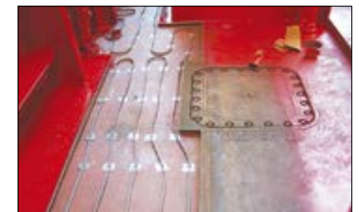
Системы обеспечения антиобледенения и удаления льда могут быть спроектированы и установлены «на палубе» или «под палубой» с термоизоляцией. У компании Термон имеется опыт работы с обоими типами систем.
