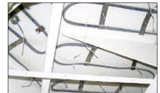
Системы обеспечения антиобледенения и удаления льда могут быть спроектированы и установлены «на палубе» или «под палубой» с термоизоляцией. У компании Термон имеется опыт работы с обоими типами систем.
